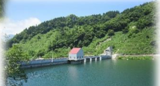
栃ヶ原ダム(高柳町栃ヶ原)
