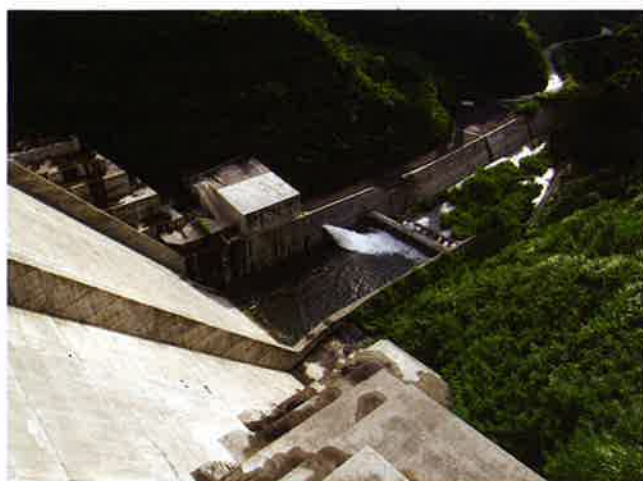
栃ヶ原ダム放流状況（H22.8）
