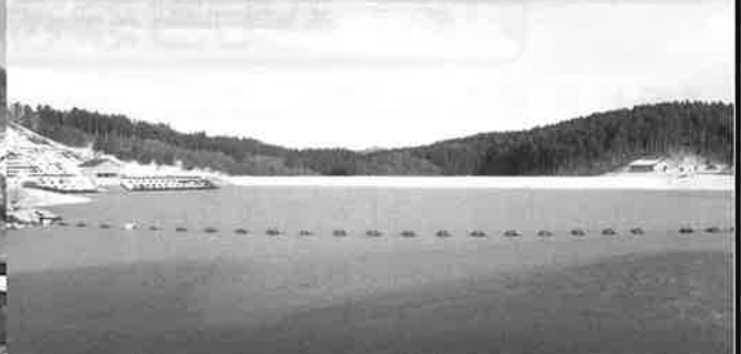
別山大橋より堤体を望む 令和2年12月19日：満水
