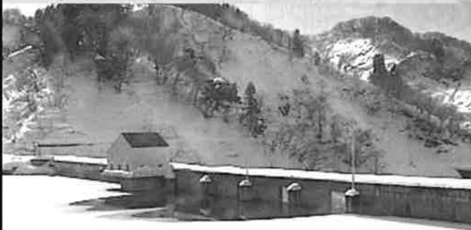
上流右岸カメラ 右岸監視カメラ 令和2年12月25日：満水
