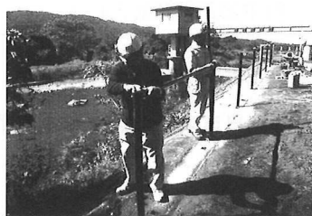
転落防止柵取替 (古町堰地区)
