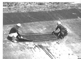
ため池遮水シート修繕(山室集落)
