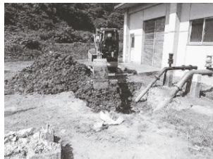
パイプライン漏水修繕(浜忠地区)
