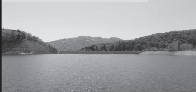
右岸より堤体を望む 令和7年12月13日満水
