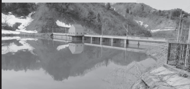
右岸より堤体を望む 令和7年12月31日満水
